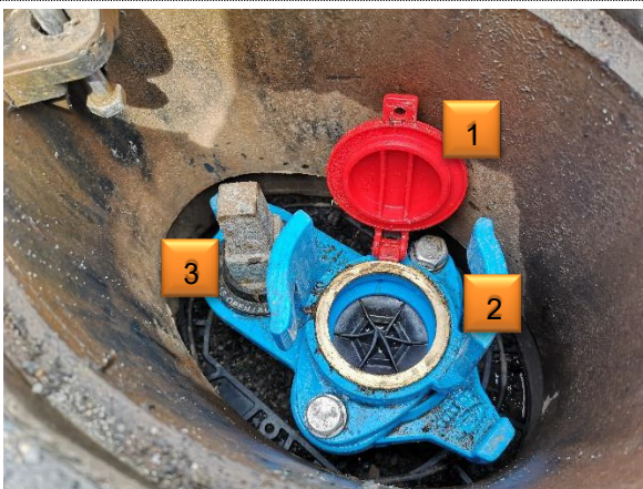
Geöffnete Hydrantenkappe
