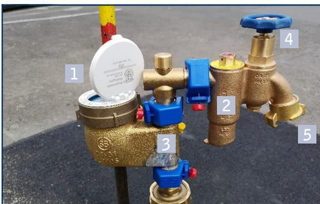
1. Wasserzähler 2. Sicherheitsarmatur (Systemtrenner)
