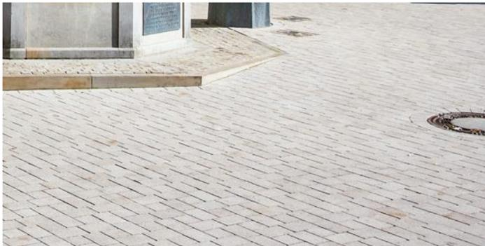
Abb. 39: Betonsteinpflaster im Verband
