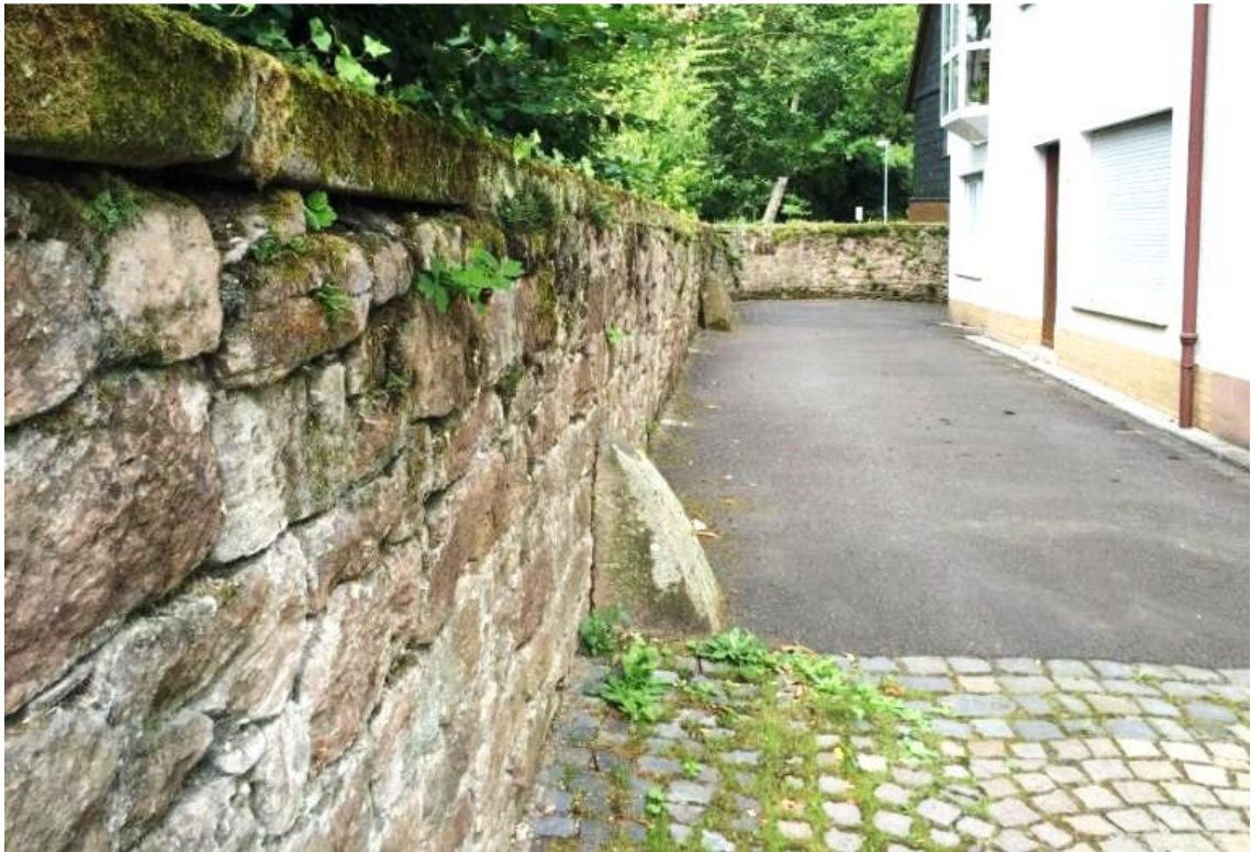
Abb. 18 Grenzmauer zur Altstadt im Süden (Foto SHK)
