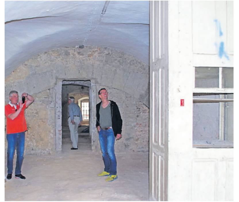
Blick in das Kellergewölbe mit dem Speisenaufzug des Schlosses.
