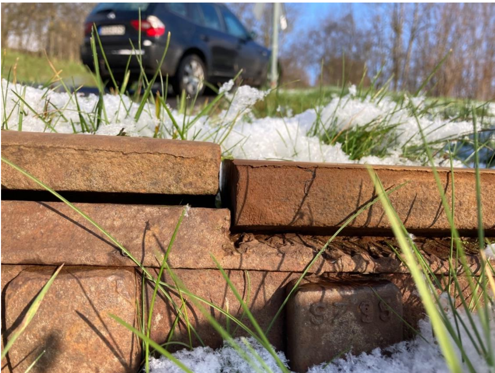
Abbildung 13-3: Versatz bei Schienenstoß
