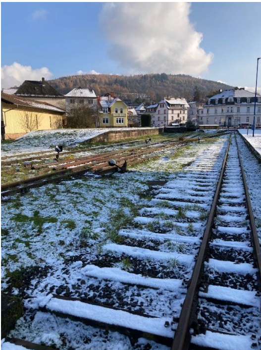
Abbildung 13-8: Gleisanlagen Bahnhof Bad Orb
